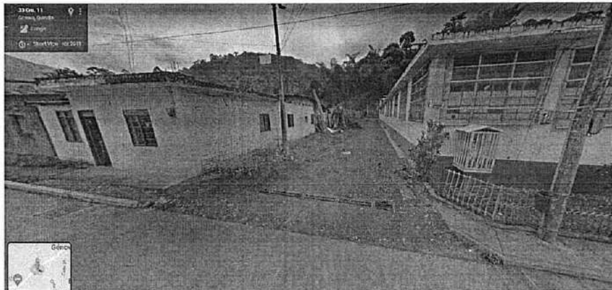
Fig 3.0 Calle 34 entre carreras 10 y 11- Genova
