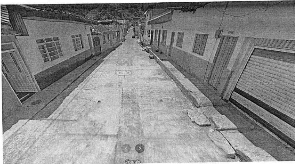
Fig 4.1 Calle 25 entre carreras 12 y 13 - Genova
