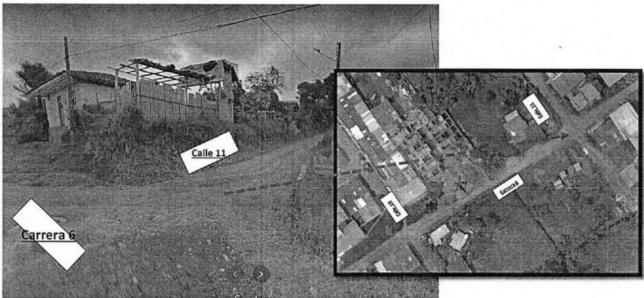
Fig 15.2 CARRERA 6 ENTRE CALLES 10 Y 11 – ACUEDUCTO (SALENTO Q.)
