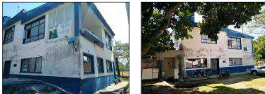
IMAG 10 - EDIFICIO CONTROL CALIDAD DEL AGUA EL EDEN
