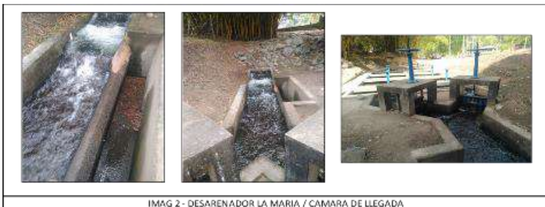
IMAG 2 - DESARENADOR LA MARIA / CAMARA DE LLEGADA
