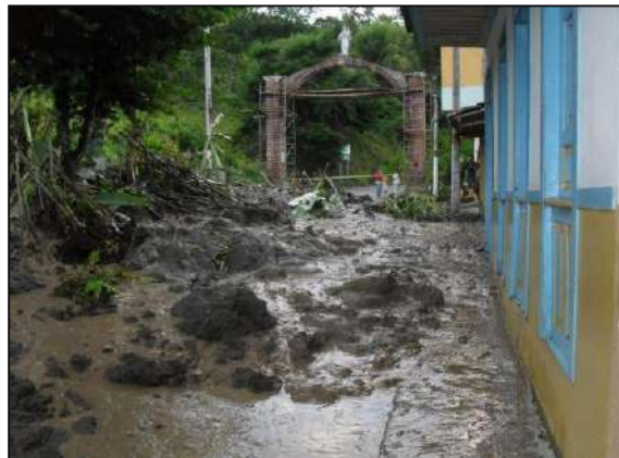
Ilustración 6. Afectación vía Principal, Sector Casuarinas
