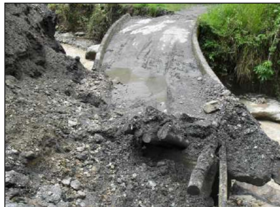
Ilustración 4. Puente sobre la Quebrada La Maicena, Vía Guacas - Génova
