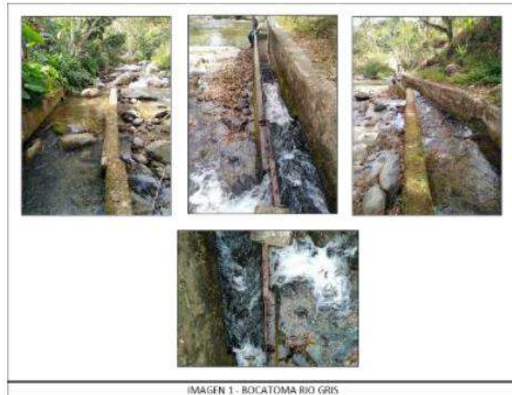
IMAGEN 1 - BOCATOMA RIO GRIS
