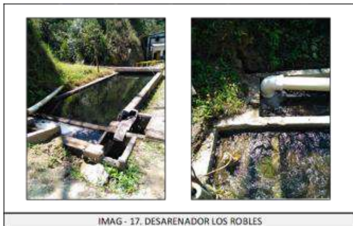
Ilustración 14 Desarenador El Roble
