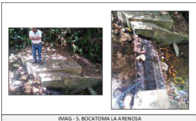
IMAG - 5. BOCATOMA LA ARENOSA
