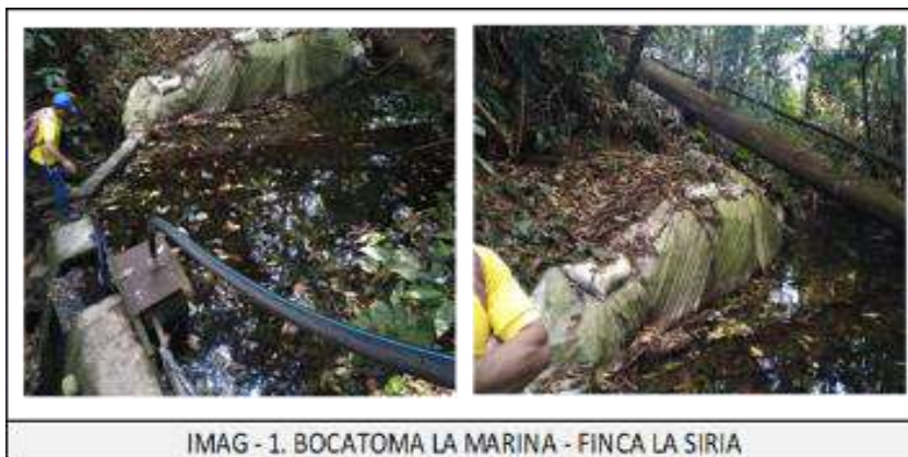
Ilustración 5 Bocatoma la marina
