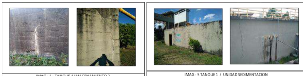
Ilustración 19 Tanque de almacenamiento y unidad de sedimentación
