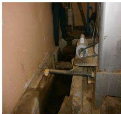
Canal para recibimiento de agua cruda
