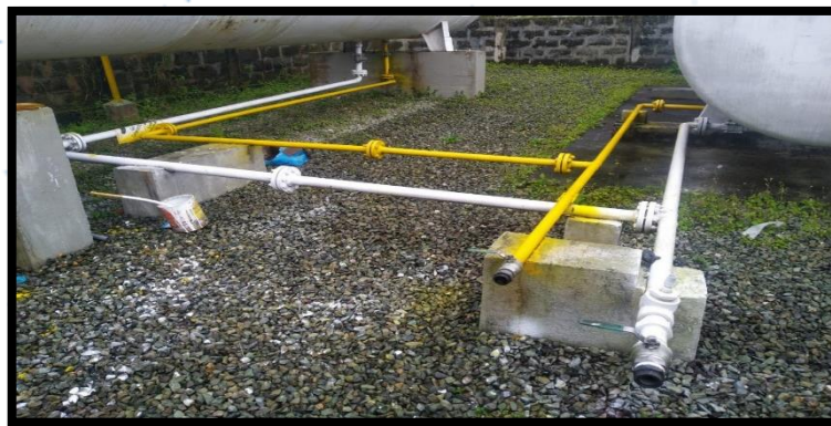
Adecuación y mantenimiento de tuberías
