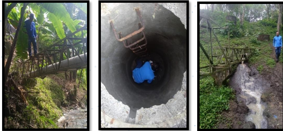
Mantenimiento de colectores
