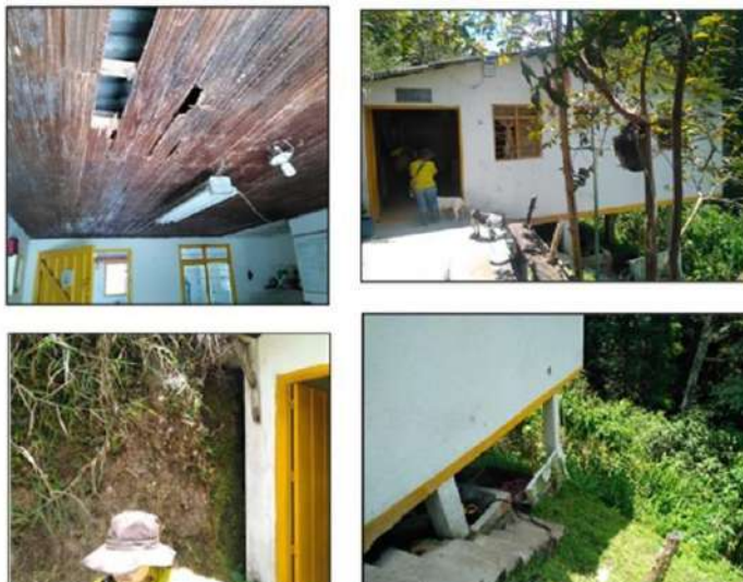
Imagen 13: Estación de Bombeo 2 Las Águilas. Fuente: Propia
