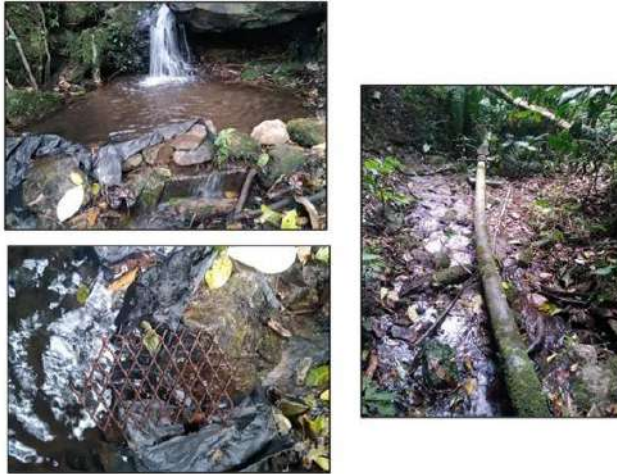
Imagen 6: Bocatoma La Cristalina. Fuente: Propia
