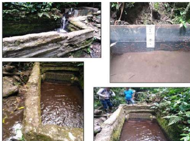
Imagen 5: Bocatoma Bolivia. Fuente: Propia
