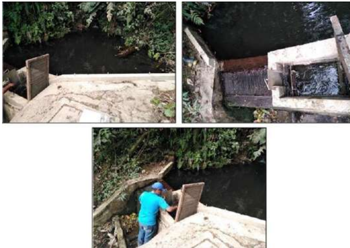
Imagen 4: Bocatoma Corozal. Fuente: Propia
