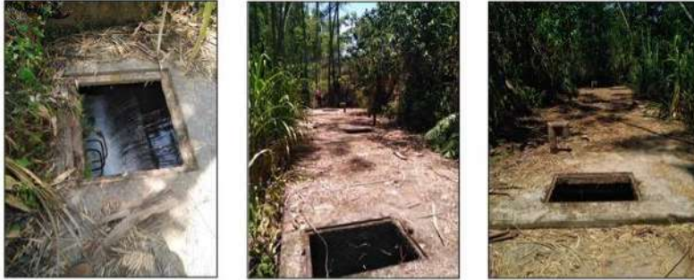
Imagen 6: Desarenador 1. Fuente: Propia
