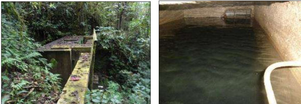
Imagen 7: Desarenador La Calzada. Fuente: Propia
