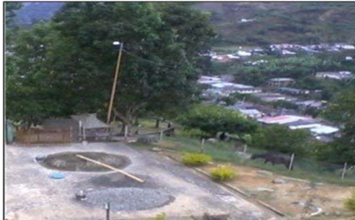
Imagen 9: Tanque de almacenamiento. Fuente: Propia
