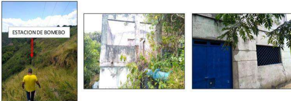
Imagen 8: Estación de bombeo. Fuente: Propia
