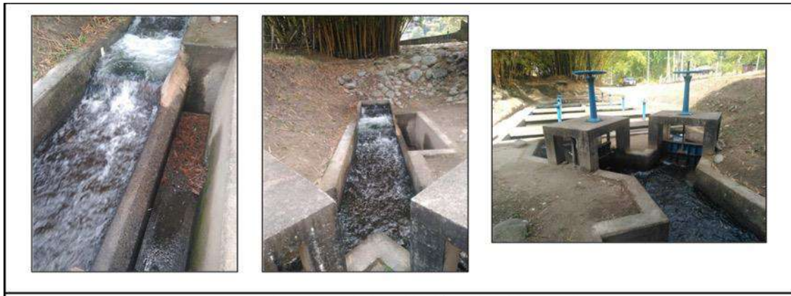
Ilustración 3 Desarenador La Marina, cámara de llegada
