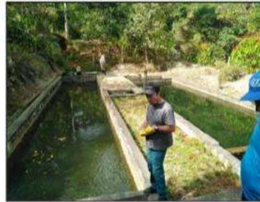
Imagen 4: Desarenador. Fuente: Propia
