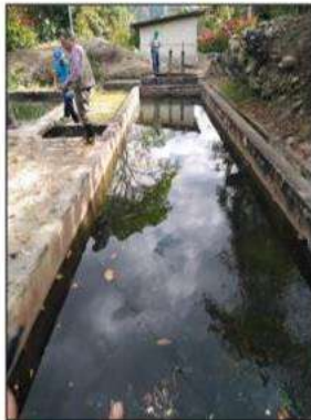
Imagen 4: Desarenador. Fuente: Propia
