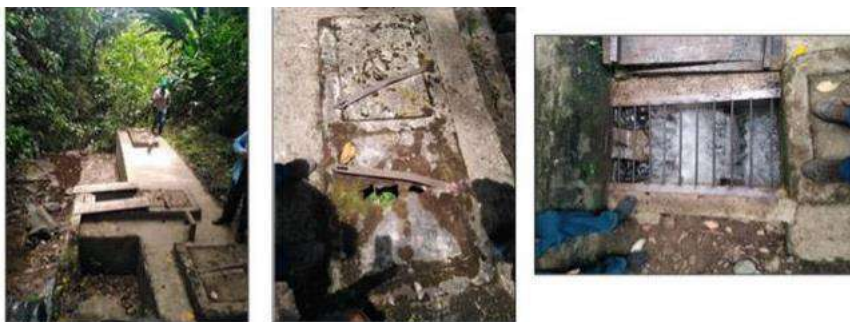
Imagen 4: Desarenador La Picota. Fuente: Propia
